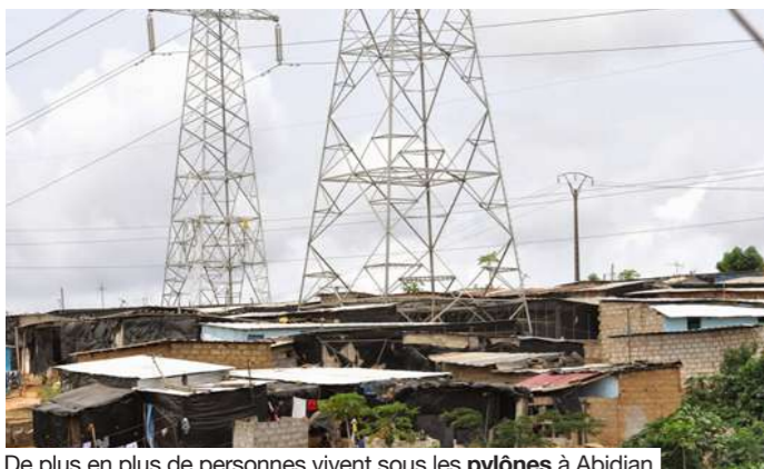
De plus en plus de personnes vivent sous les pylônes à Abidjan.
